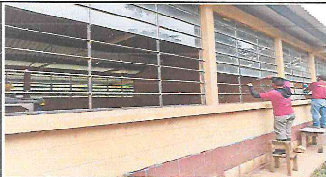
Foto 1: Se observa el mantenimiento de las ventanas
