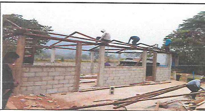
Foto 5: Se observa techado de la cocina
