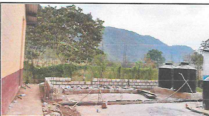
Foto 3: Se observa el inicio de la construccion de la cocina
