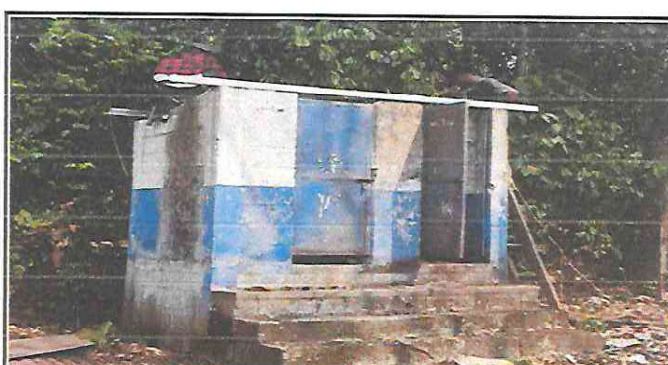
Foto 6: Se observa el cambio del techado del baño
