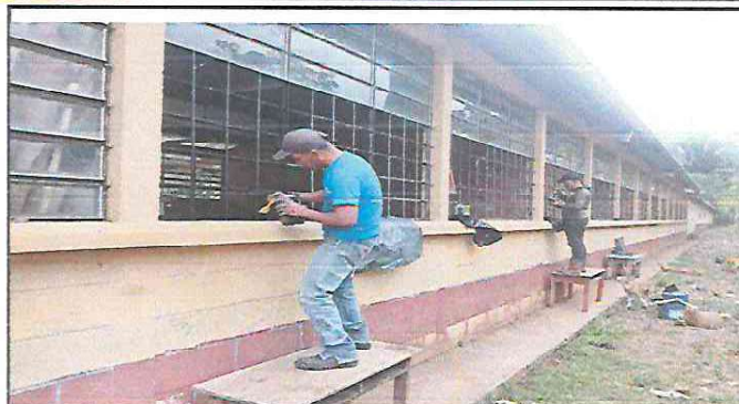
Foto 2: Se Observa instalacion de balcones
